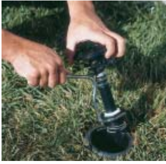
1. Remueva el interior del aspersor existente.
