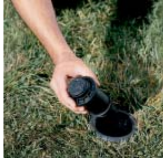
2. Enrosque todo el cuerpo/emergente ATR en la base existente.
